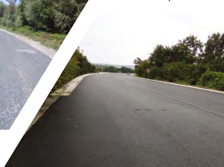
Chaussée après travaux ▼
